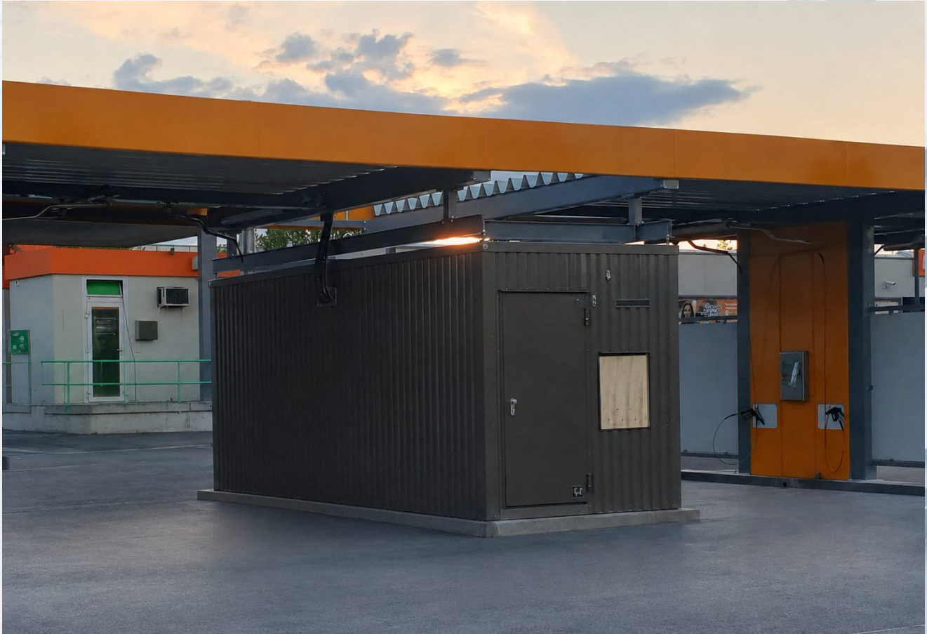
Container mit Stützrahmen für Altanlagen zur sicheren Abfangung bestehender Anlagenteile
