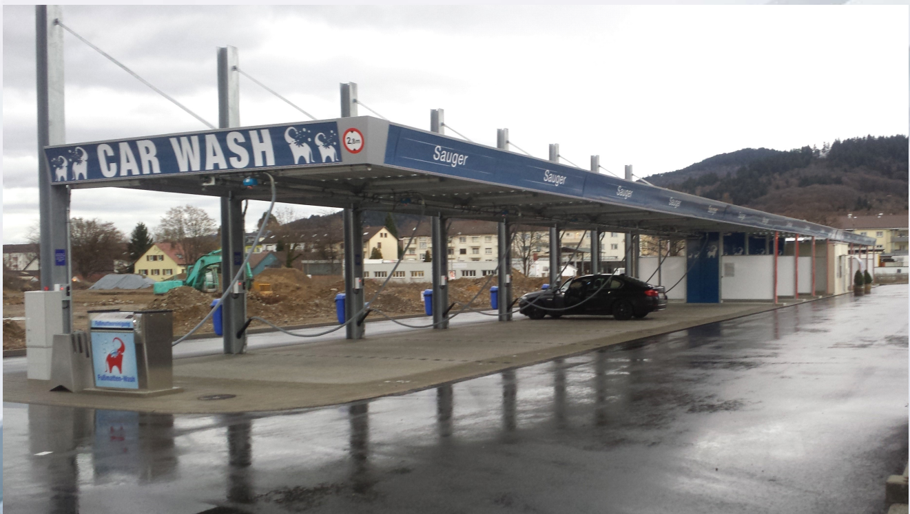
Freitragende Saugerüberdachung mit Anschluss an Lightstahlbau
