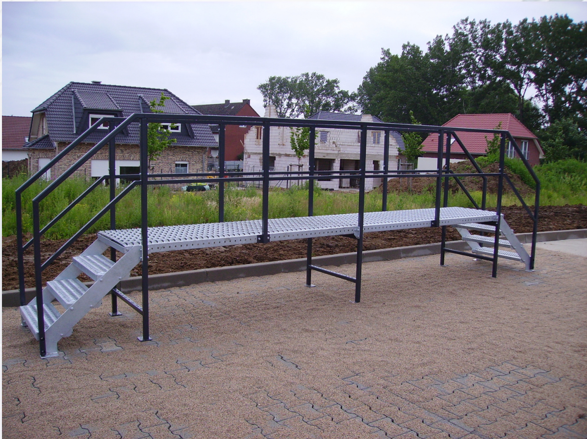
Doppelseitiger Laufsteg mit einer Höhe von 0,8m
